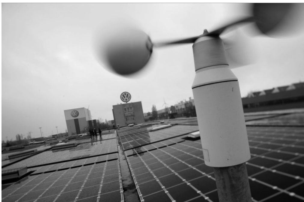
Lichtkraft Nord installierte die Photovoltaikanlage für die VW-Belegschaftsgenossenschaft
